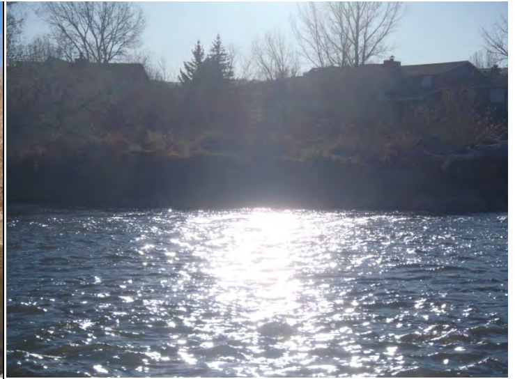
Rock Toe-Pipe Map-1-004
